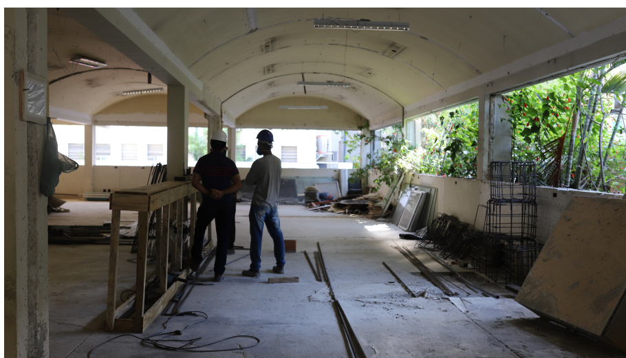
Acompanhamento das obras
